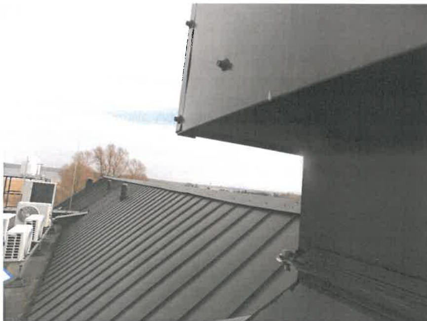
Rysunek 2 Zdjęcie dachu dwuspadowego
