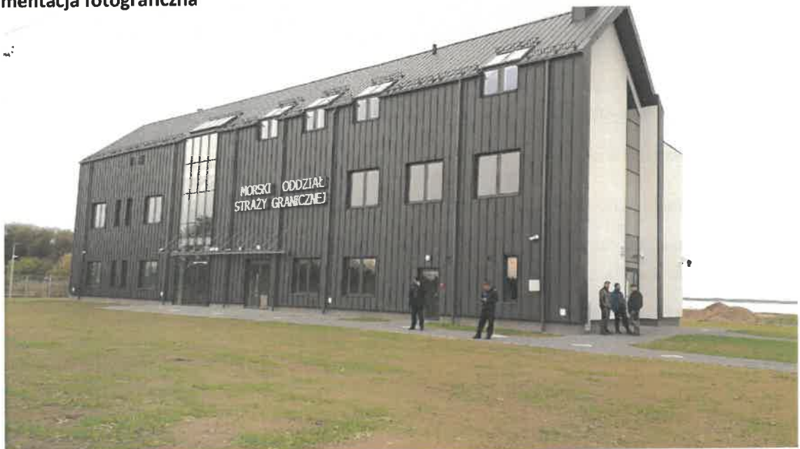
Rysunek 1 Zdjęcie budynku administracyjno-biurowego
