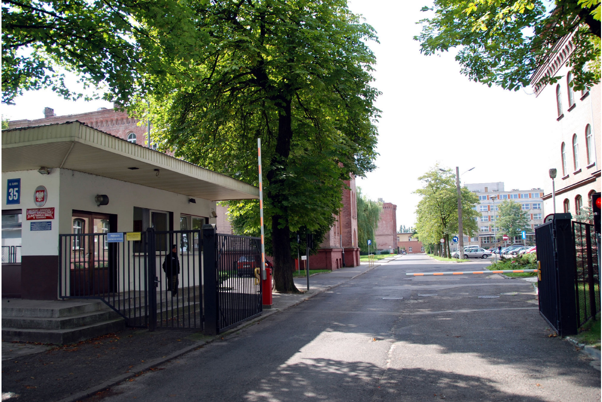
Brama wjazdowa do Komendy Morskiego Oddziału Straży Granicznej.
