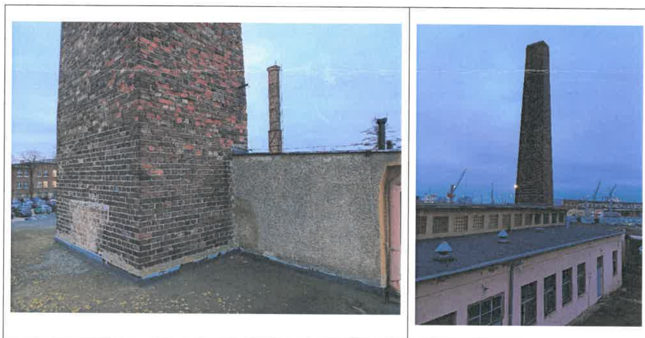
Komin nr 2- stopa fundamentowa żelbetowa pełna, trzon wykonany z cegły, ze stopniami z płaskowników.
